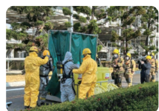
化學處理班進行除污作業
